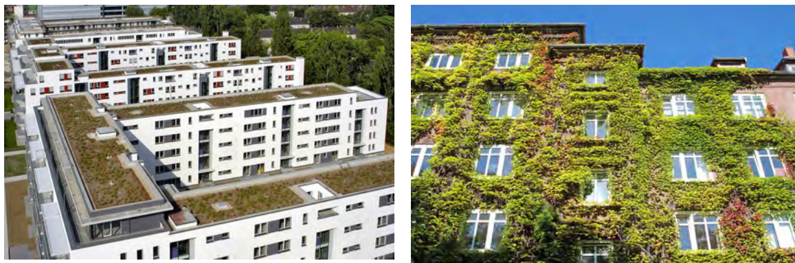
Abbildung 20: Beispiele für Dach- und Fassadenbegrünungen
